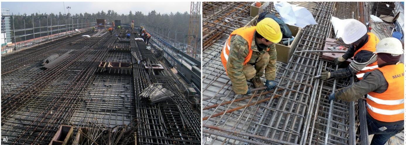
**Bild 4** a) Hochbewehrte Streben des Bewehrungs-Fachwerkes inkl. Einbauteil und dahinter liegendem Lüftungsdurchbruch; b) Einbau der diagonalen Rückhängebewehrung am Einbauteil
