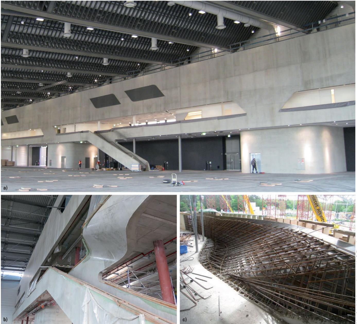
**Bild 6** a) Hallenseitige Sichtbetonwand; b) Gekrümmte Brüstung über der Galerietreppe; c) Gekrümmte Brüstung mit noch zu vervollständigender Bewehrung
