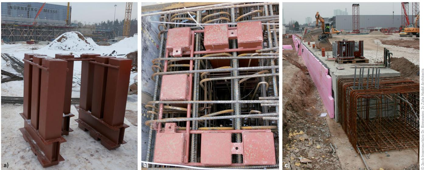
**Bild 2** a) Einbauteil der Hauptstützen vor dem Einbau; b) Einbauteil und Bewehrungsgassen wurden optimal aufeinander abgestimmt; c) Pfahlbalken mit Anschlussbewehrung für Folgetakt inkl. Einbauteil der Nebenstützen
