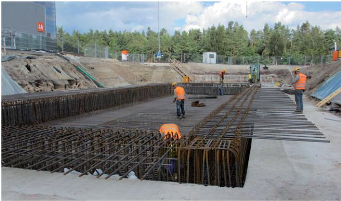
**Bild 1** Bewehrung eines biegesteifen Sohlversprungs des Riegelbauwerkes
