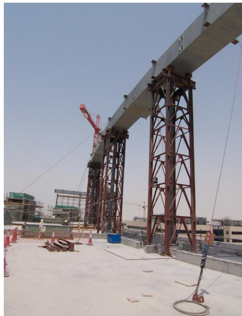
Bild 18. Nutzung der Stütztürme als temporäre horizontale Halterung
