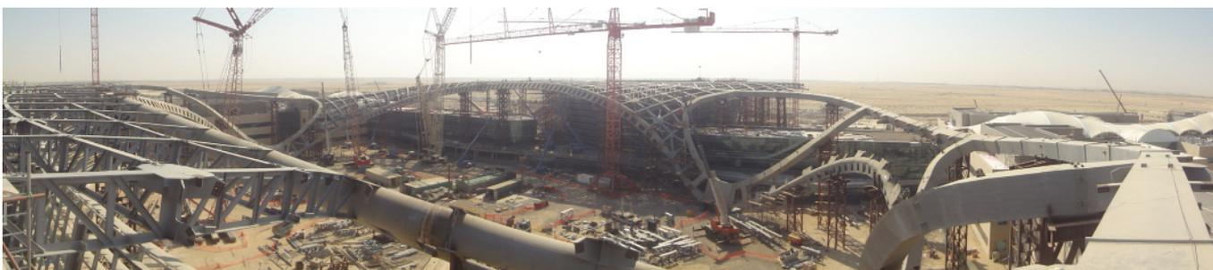
Bild 19. Montage der sekundären Struktur im Nachlauf zur primären Ringstruktur
