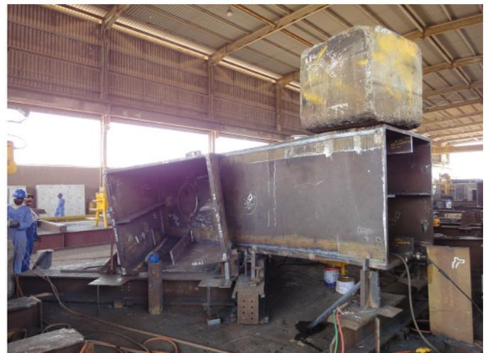
Bild 22. Vorfertigung geschweißter Segmente im Werk (links: Druckring, rechts: Kreuzungspunkt Zugring)
