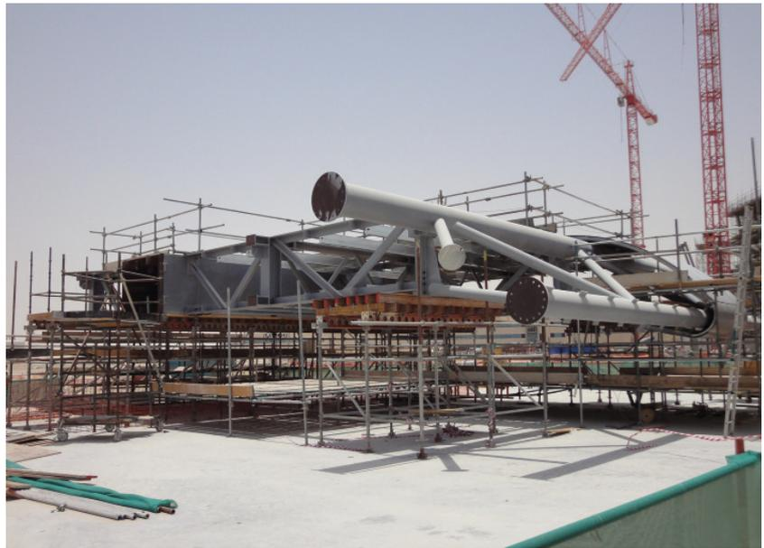
Bild 21. Mock-up für Stahlbau und Dachhaut
