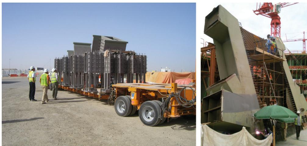
Bild 12. Einbauteile Pfahlkopfplatte (links) und Stahlbau integraler Festpunkt (rechts)
