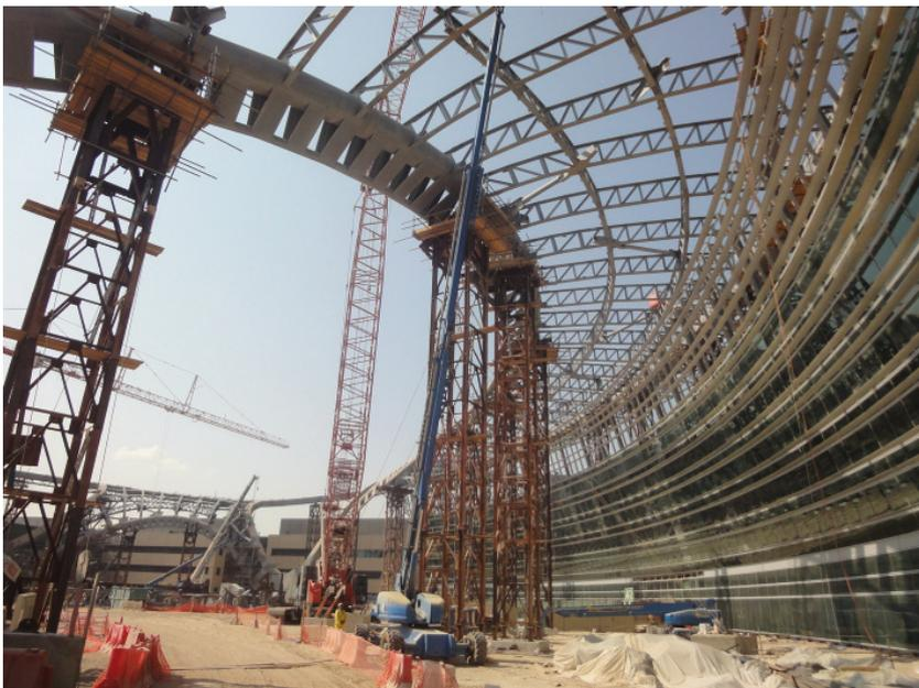
Bild 17. Stütztürme unter primärer Ringstruktur
